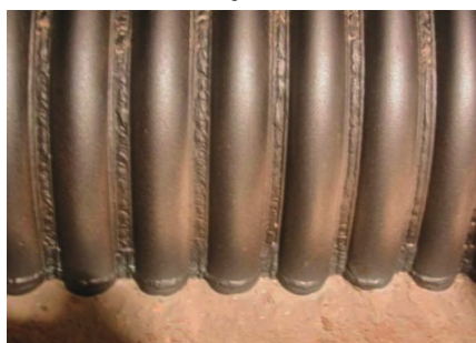
图 18 金属喷涂后的水冷壁管
